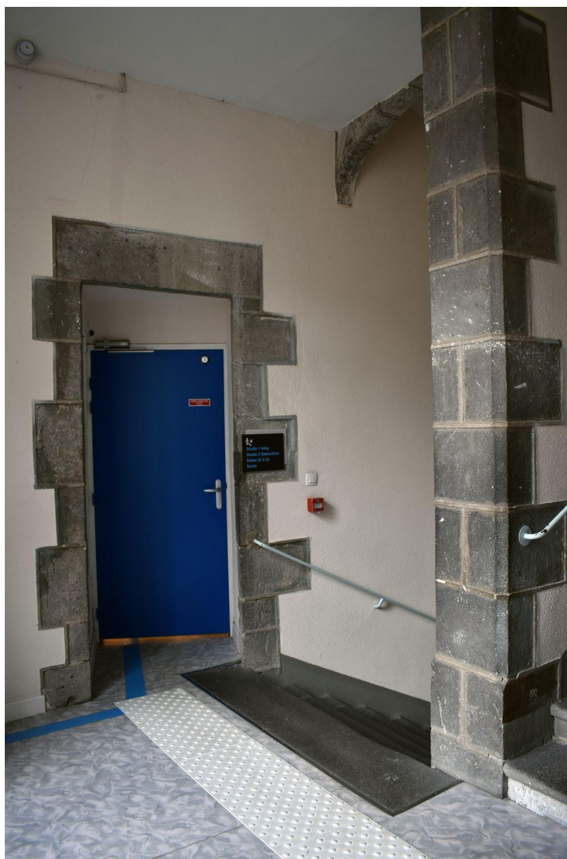
Bâtiment B : palier de l'escalier C et porte desservant le couloir du 1er étage
