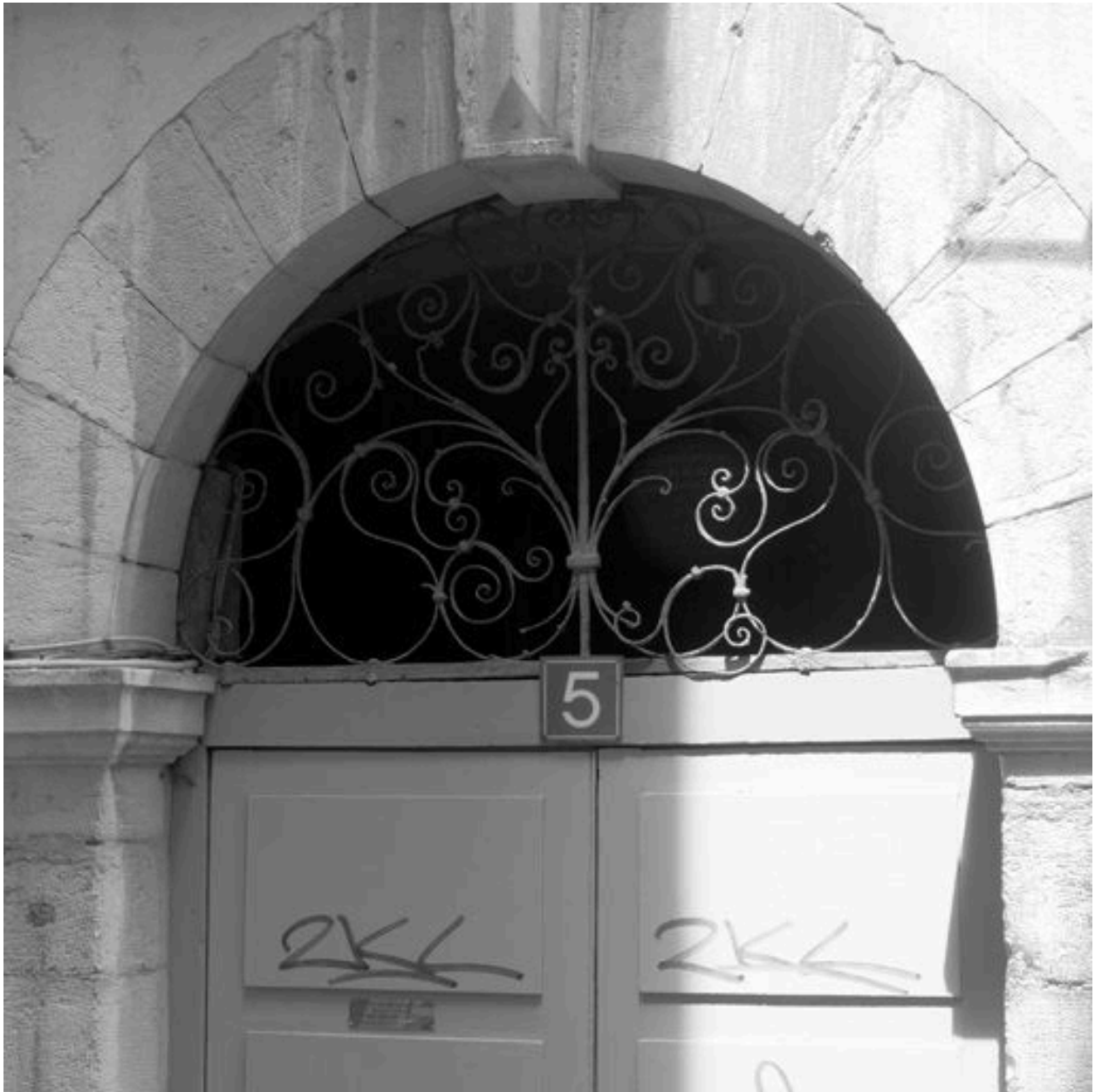
Façade, porte, détail du tympan de ferronnerie
