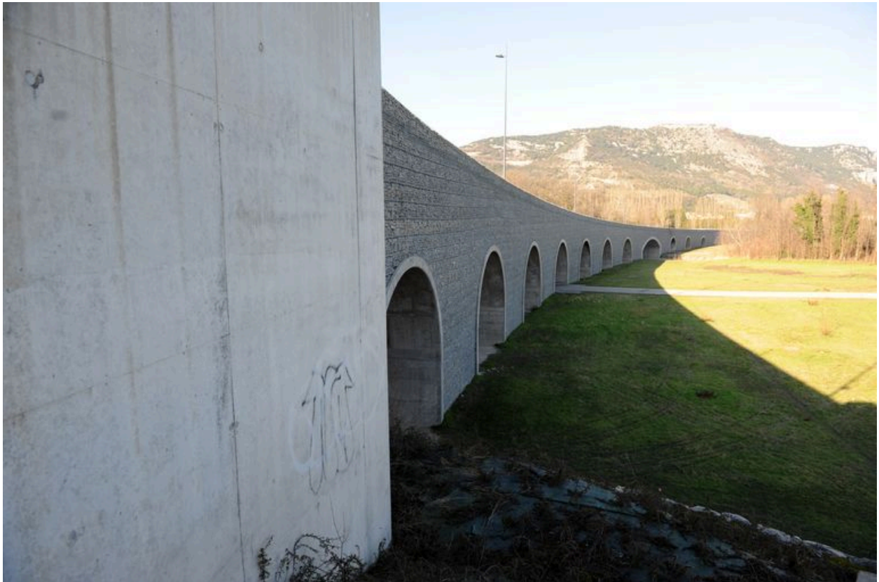
Rampe d'accès droite, face amont, vue générale (depuis la rive droite)
