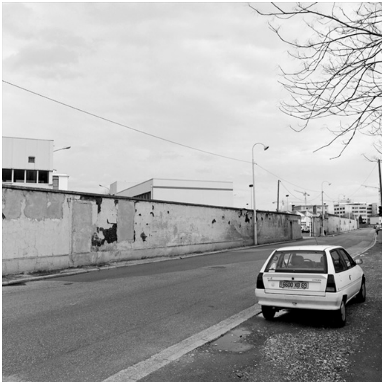
Façade sud rue Pré-Gaudry
