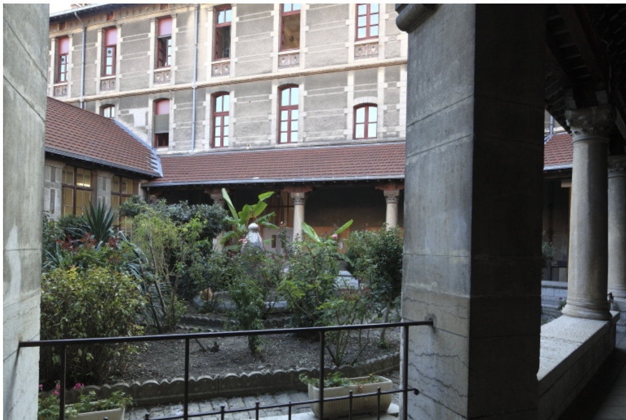
Cour G. Parterre central et bâtiment de fond.
