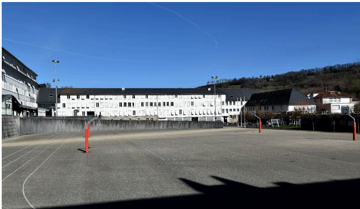
Vue de la cour principale, depuis le sud-ouest
