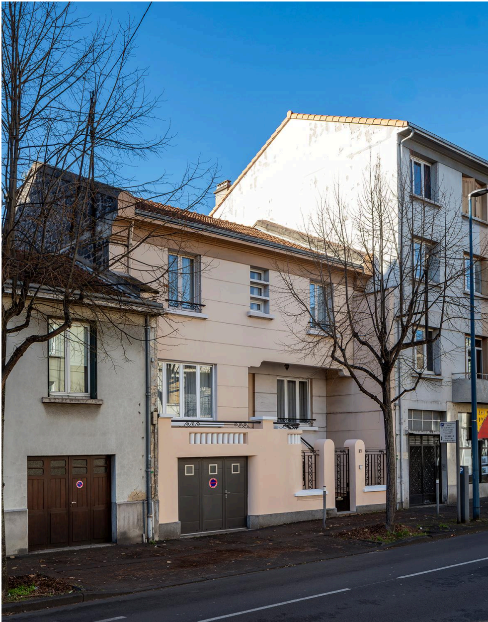
Façade sur le boulevard Jean-Jaurès
