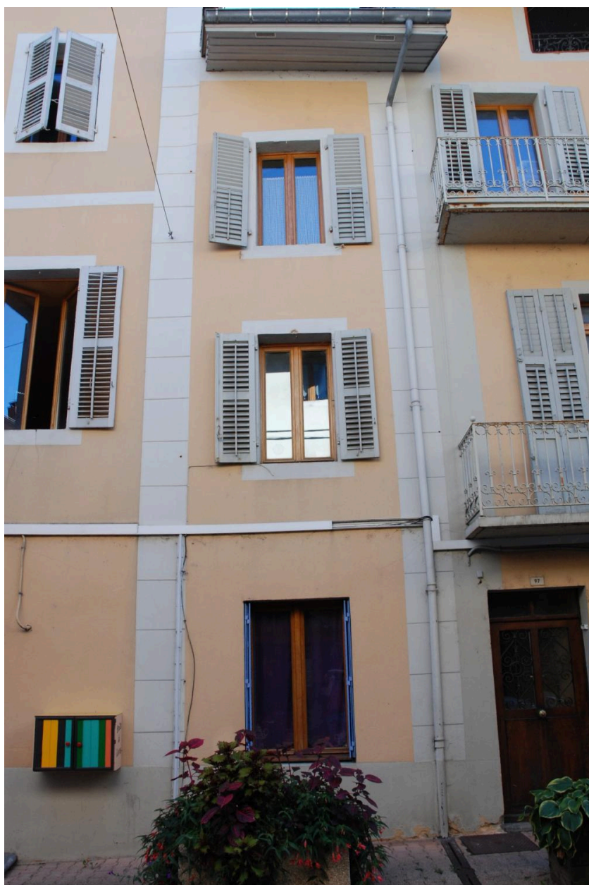
Vue d'ensemble de la façade sur la rue (n°97 bis).
