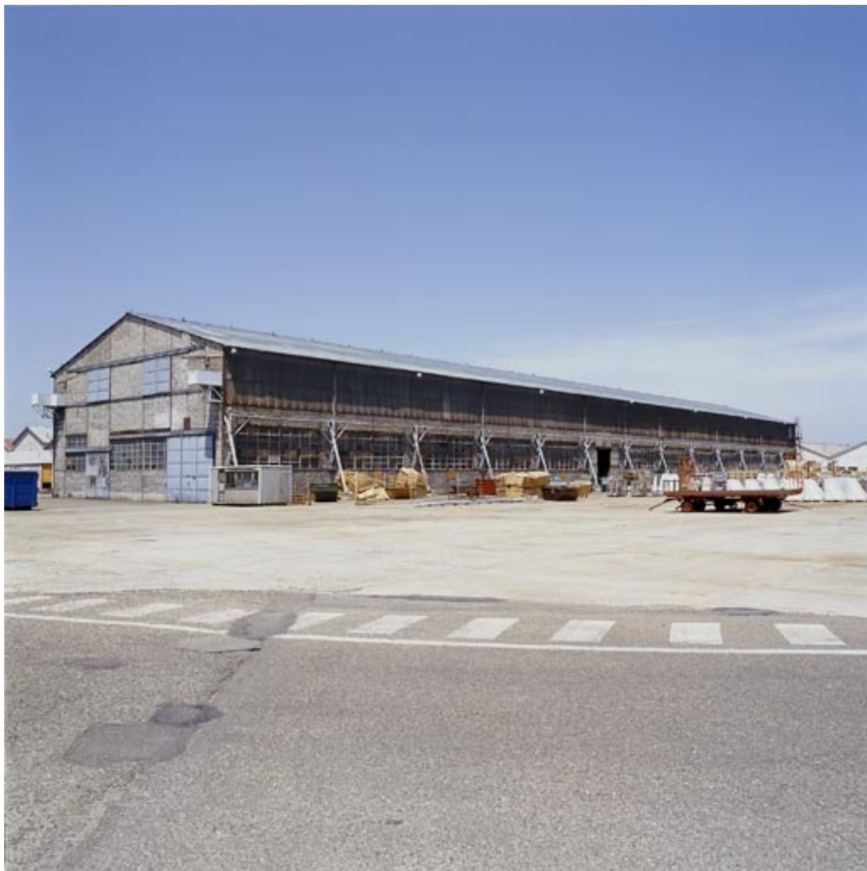
CDIPR, bâtiment C23, près de la porte D du site.
