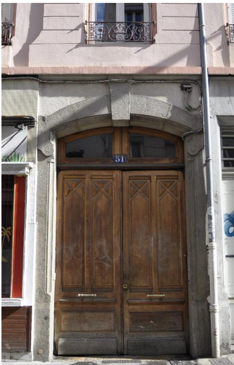
Elévation sur rue, détail de la porte cochère
