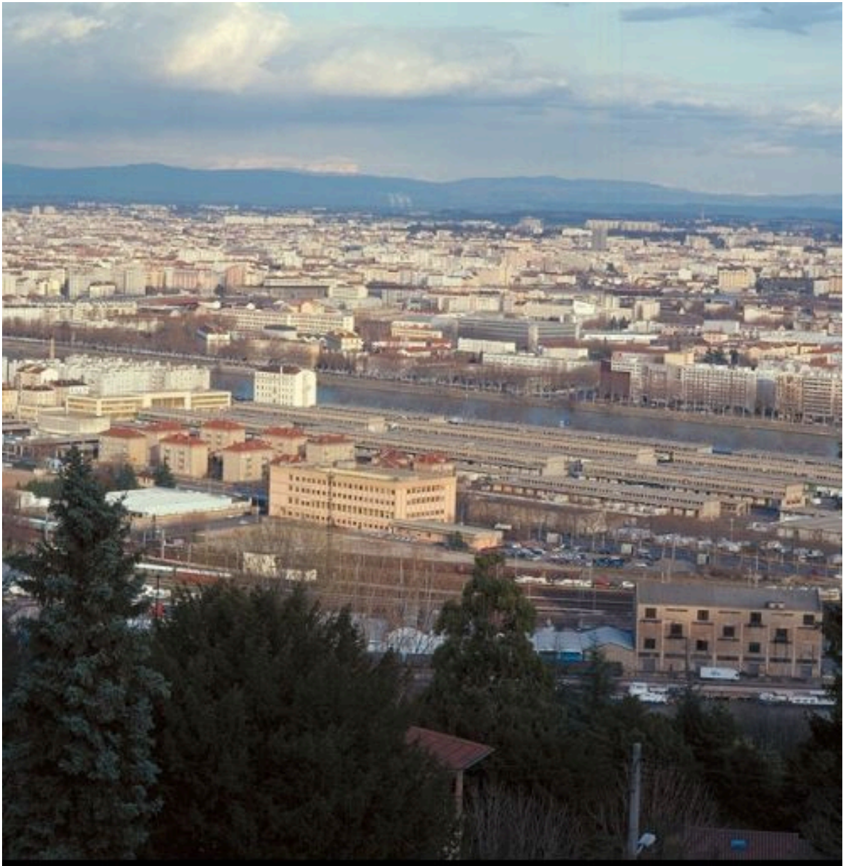
Vue générale de la partie sud du quartier depuis la place J.-D. Trait, à Sainte-Foy-les-Lyon
