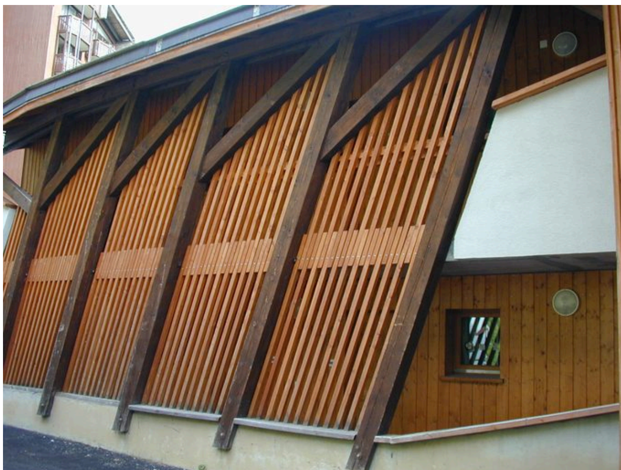
Vue extérieure de la cursive amont
