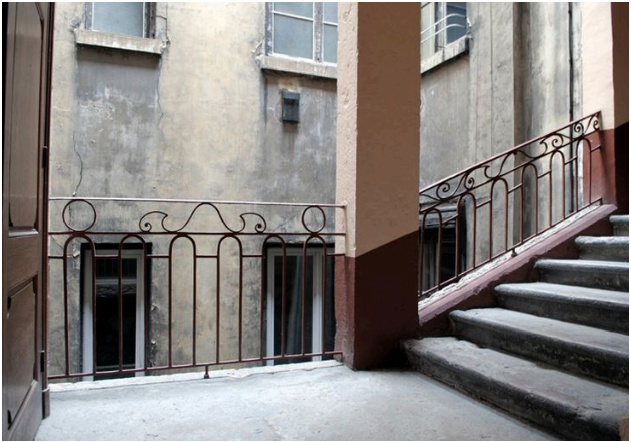
Cage d'escalier, repos entre le deuxième et troisième étage avec baies sur cour.
