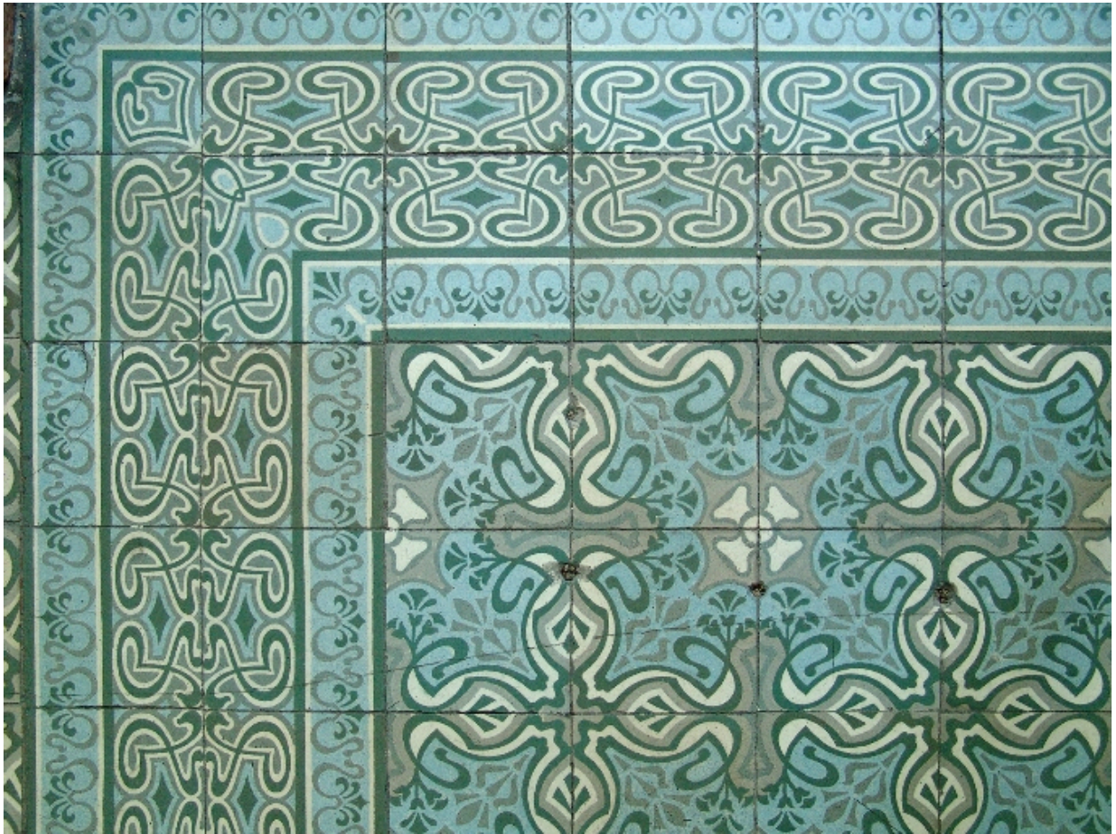
Carrelage du palier du 1er étage, détail
