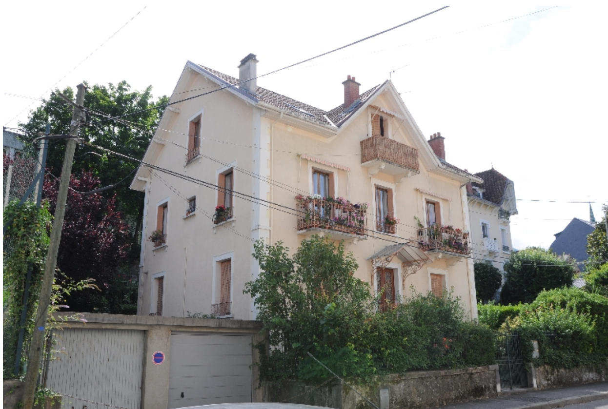
Vue générale depuis le nord
