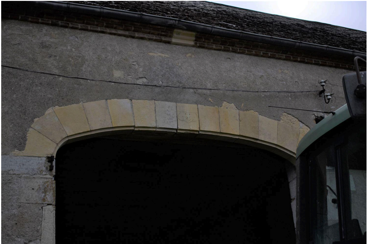
Détail de la grange : arc en anse de panier portant la date à la clef.
