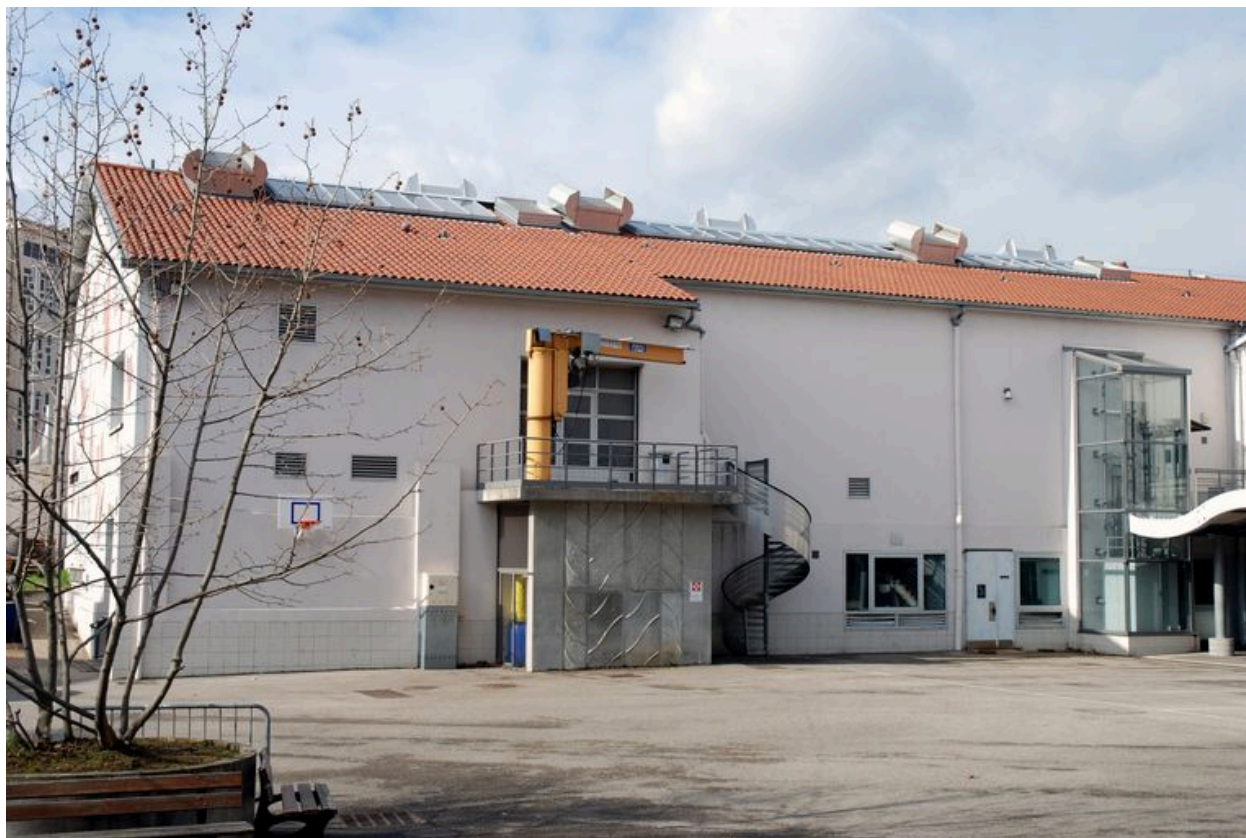
Bâtiment D : vue générale
