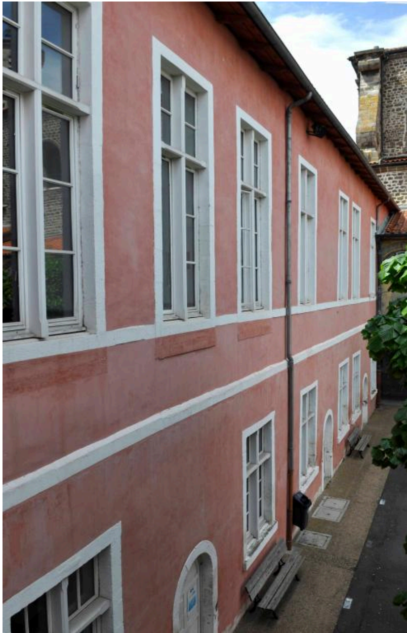
Bâtiment A : élévation sur cour 3
