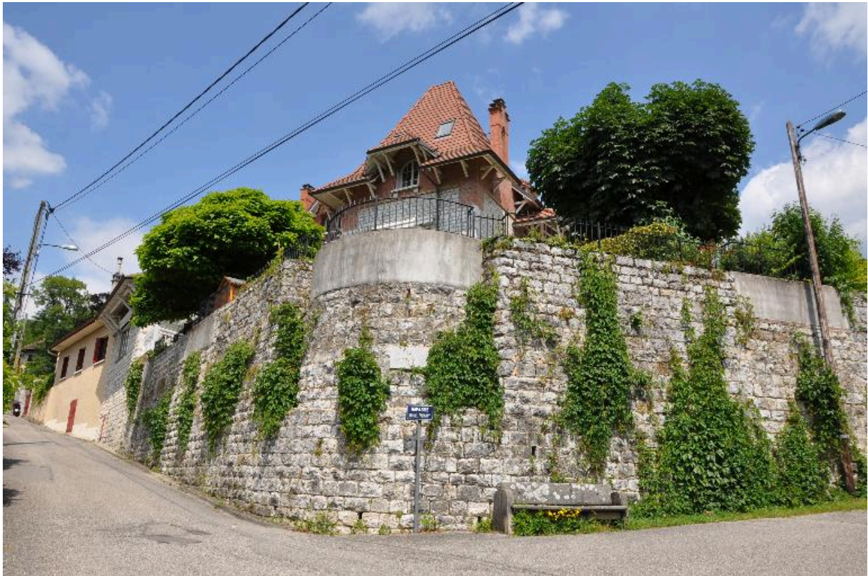
Mur de soutènement de la propriété, angle chemin A. Toudouze et impasse M. Faraday
