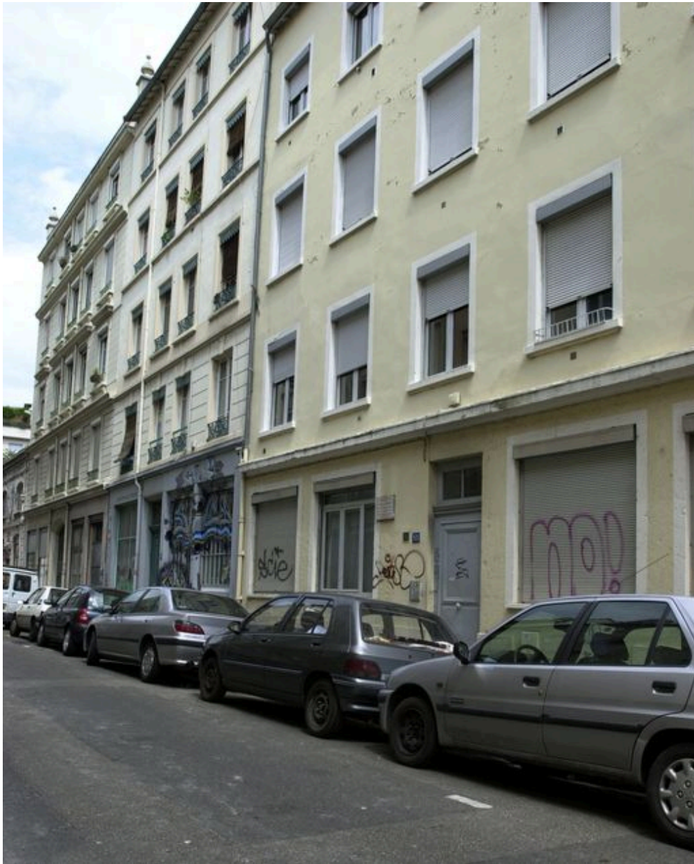
Elévation rue Saint-Michel depuis l'est
