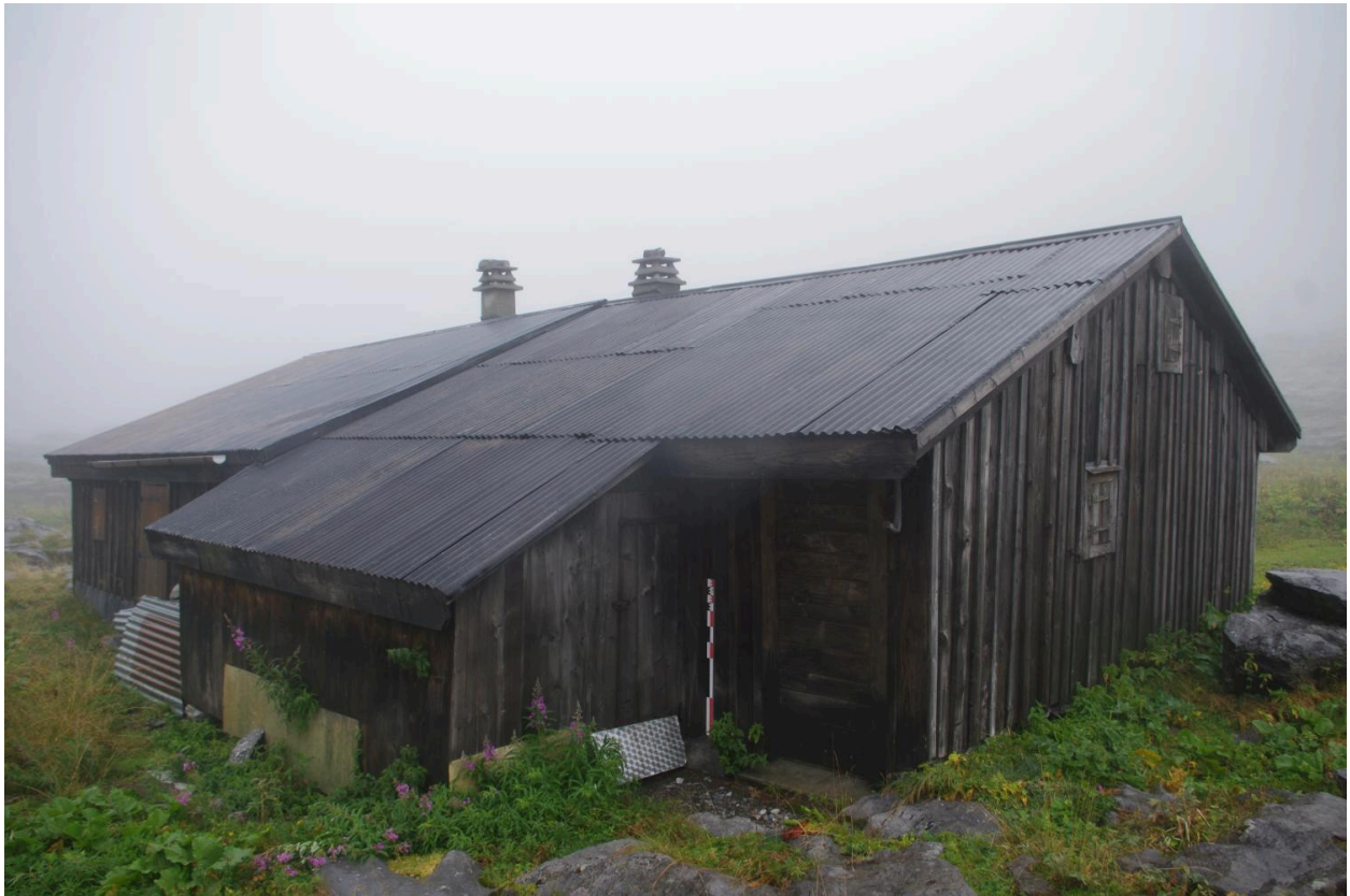
Vue de l'élévation sud-ouest
