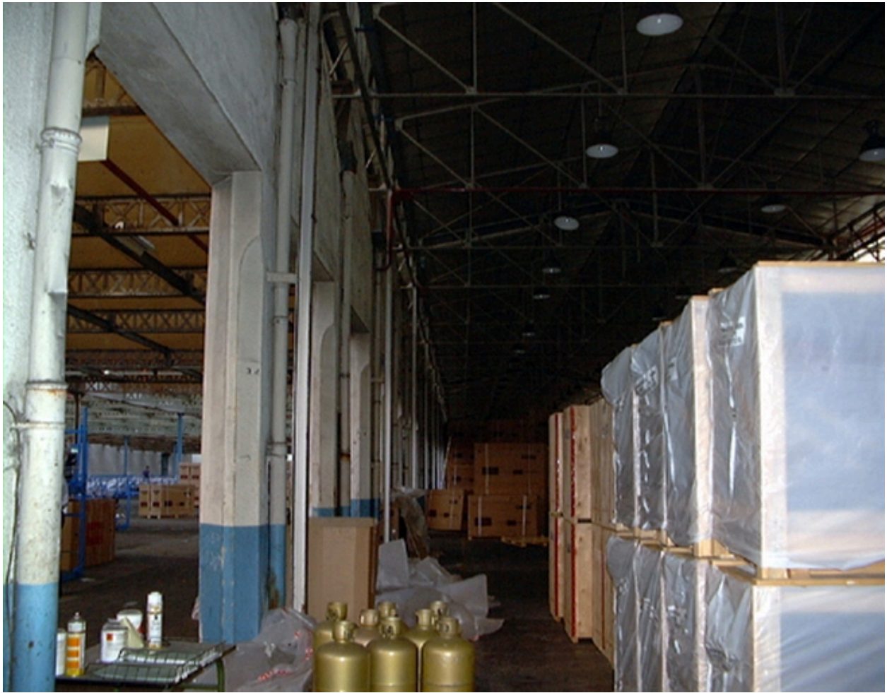
Stockage sous passage couvert
