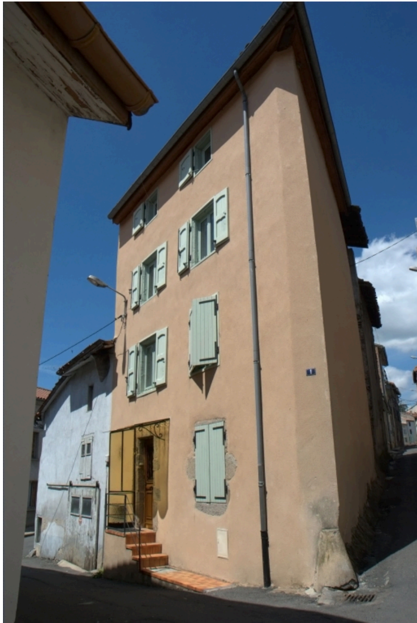
Îlot 6.Veloutiers (rue des) 01. Vue générale de la façade sur l'angle de la rue.
