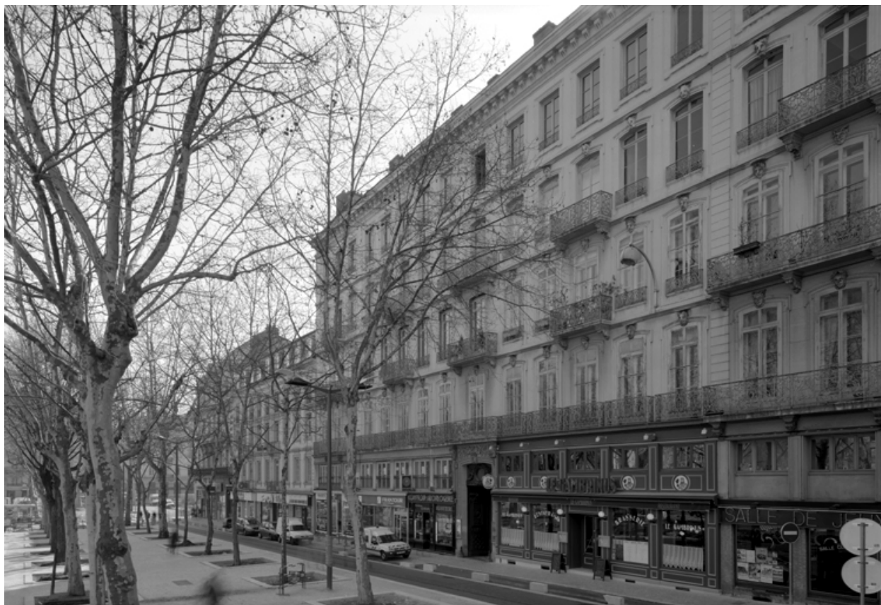
Façades des immeubles sur la place (n° 5 à droite)
