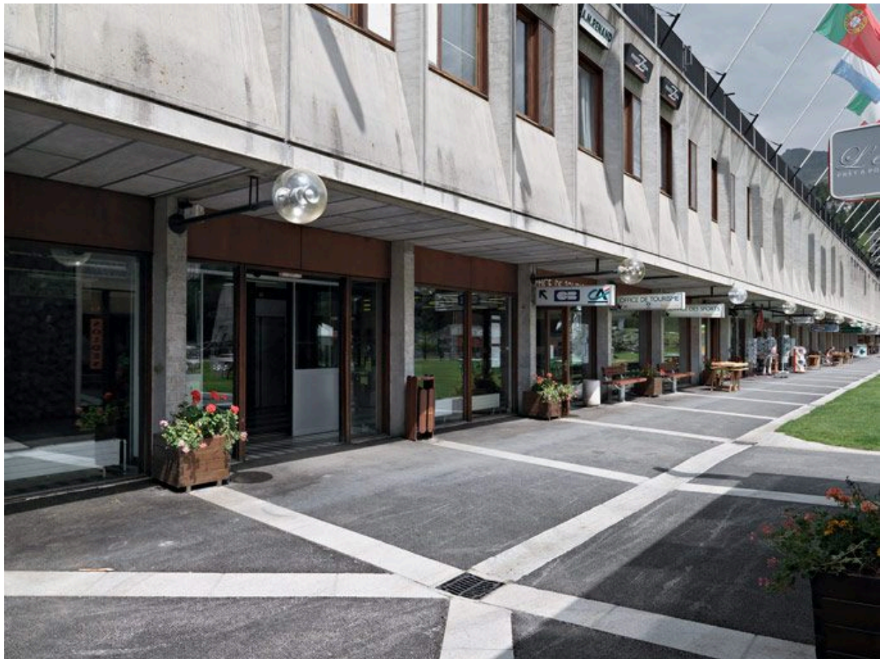
Vue d'ensemble des boutiques ouvrant sur le Forum, depuis l'ouest
