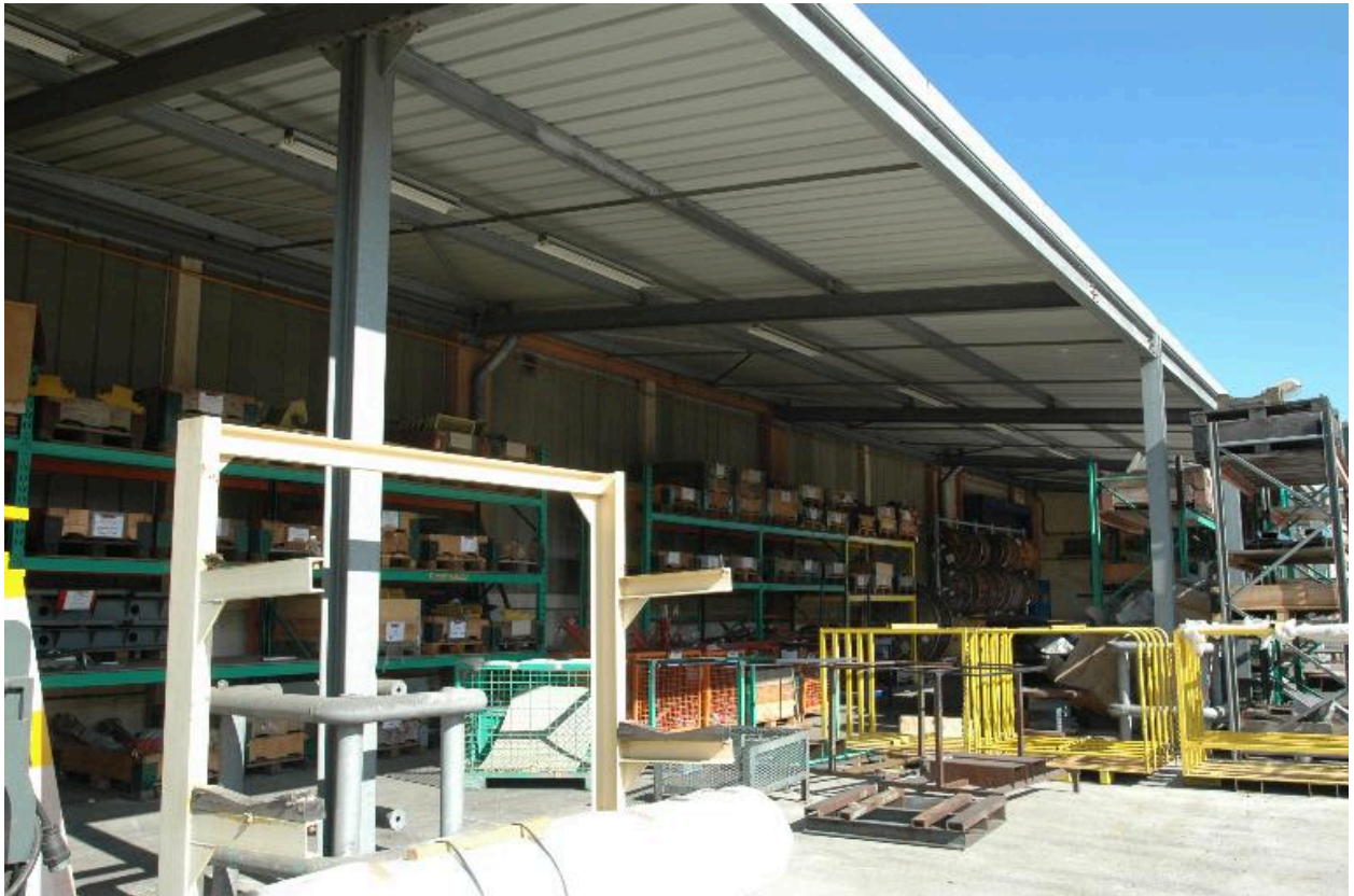
Vue extérieure zone de stockage
