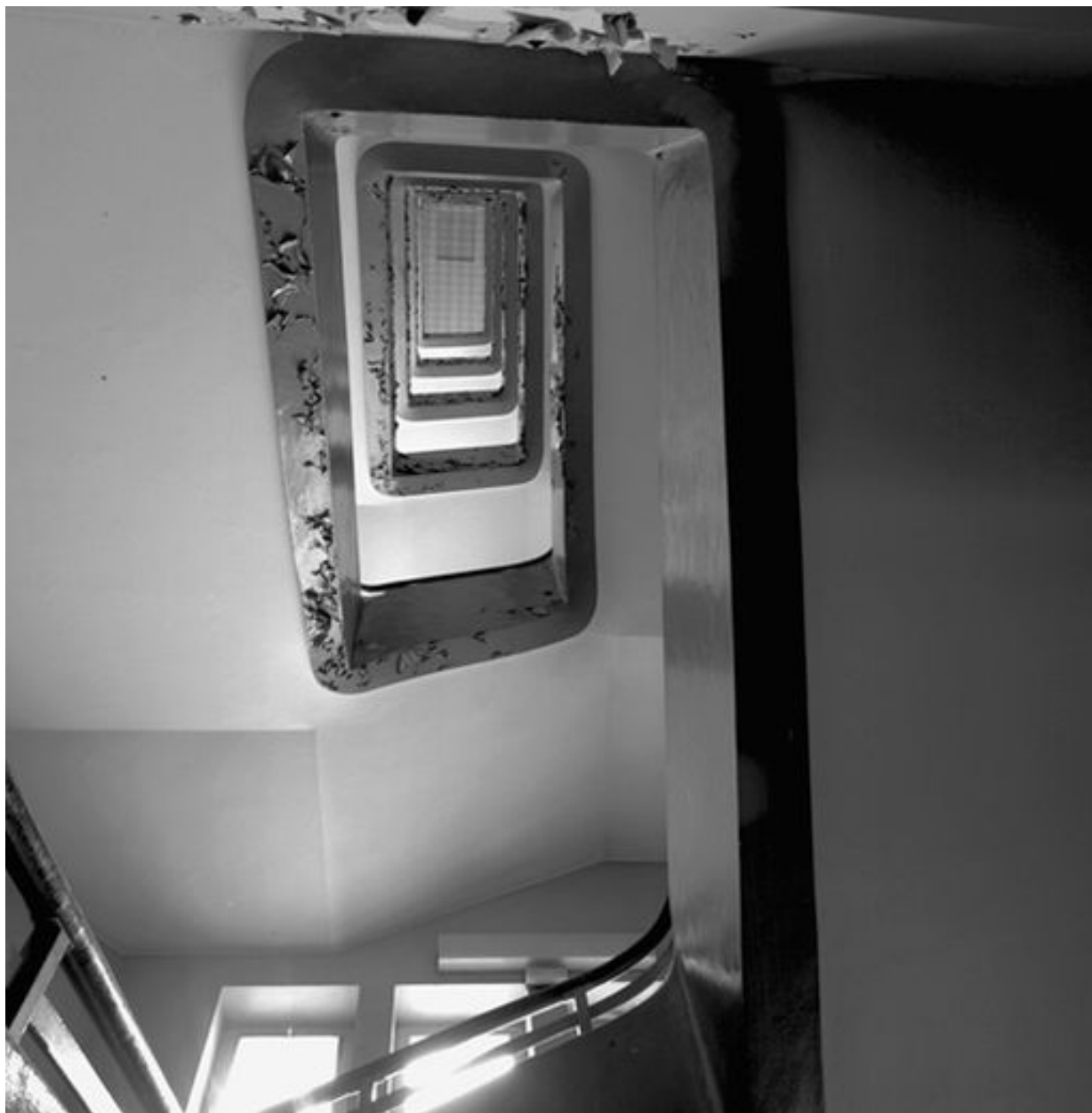
Vue de l'escalier en contre-plongée depuis le rez-de-chaussée
