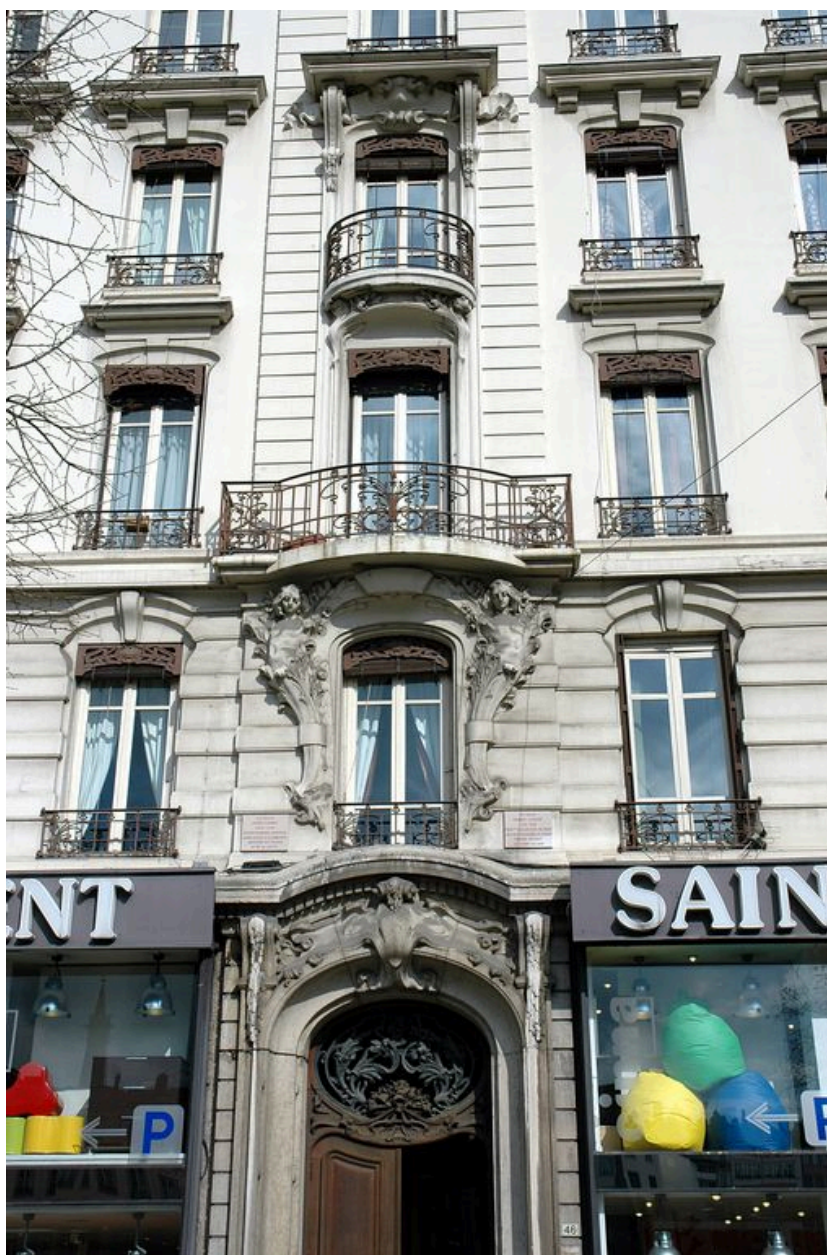
Détail de l'élévation antérieure
