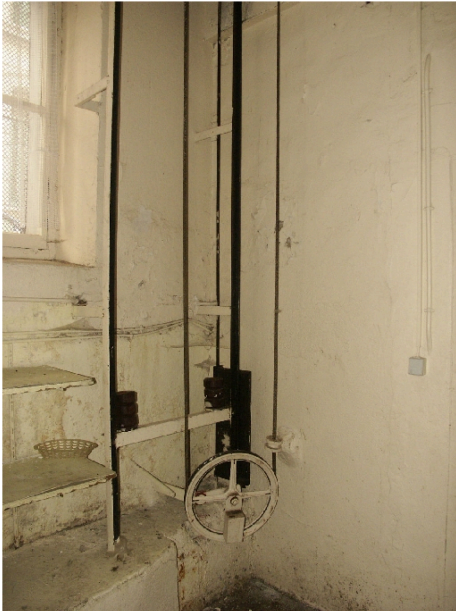
Cuisines : détail du monte-charge
