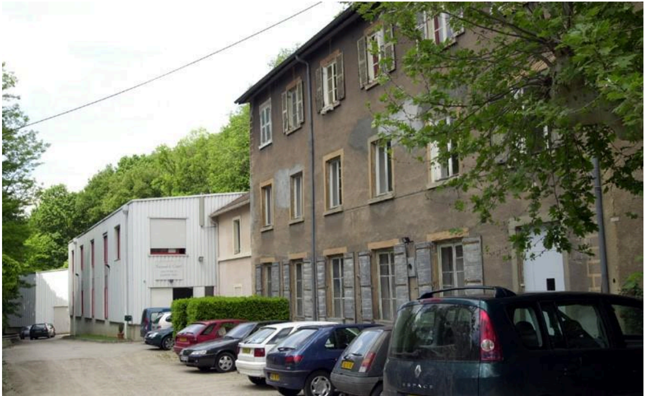
Vue d'ensemble du site de Fontaine
