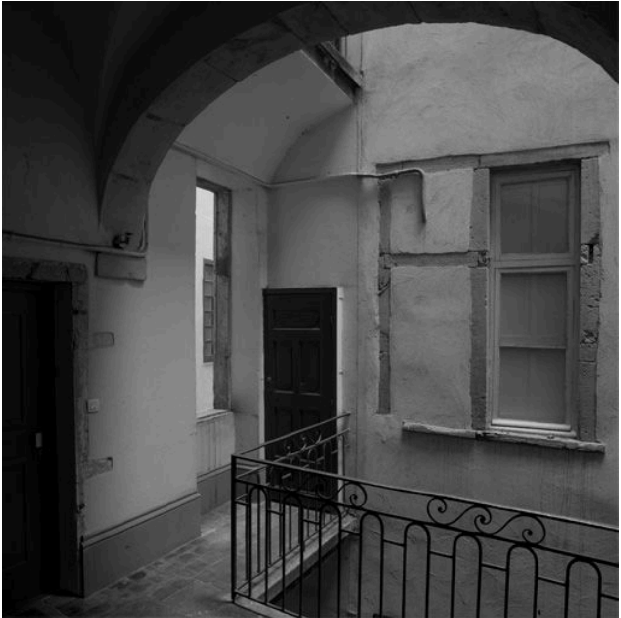
2e cour, coursière conduisant aux anciens lieux d'aisance, vue à hauteur du 2e étage
