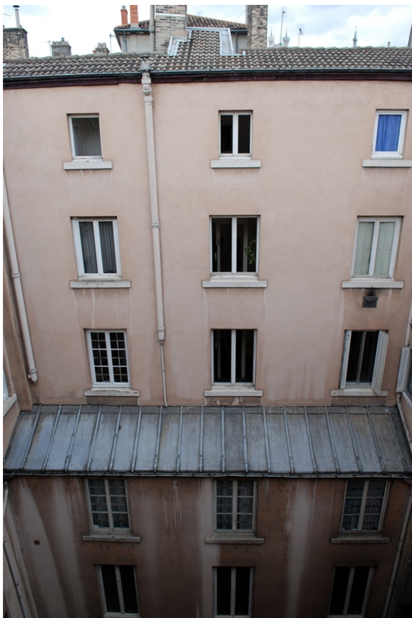
La cour principale : élévation ouest
