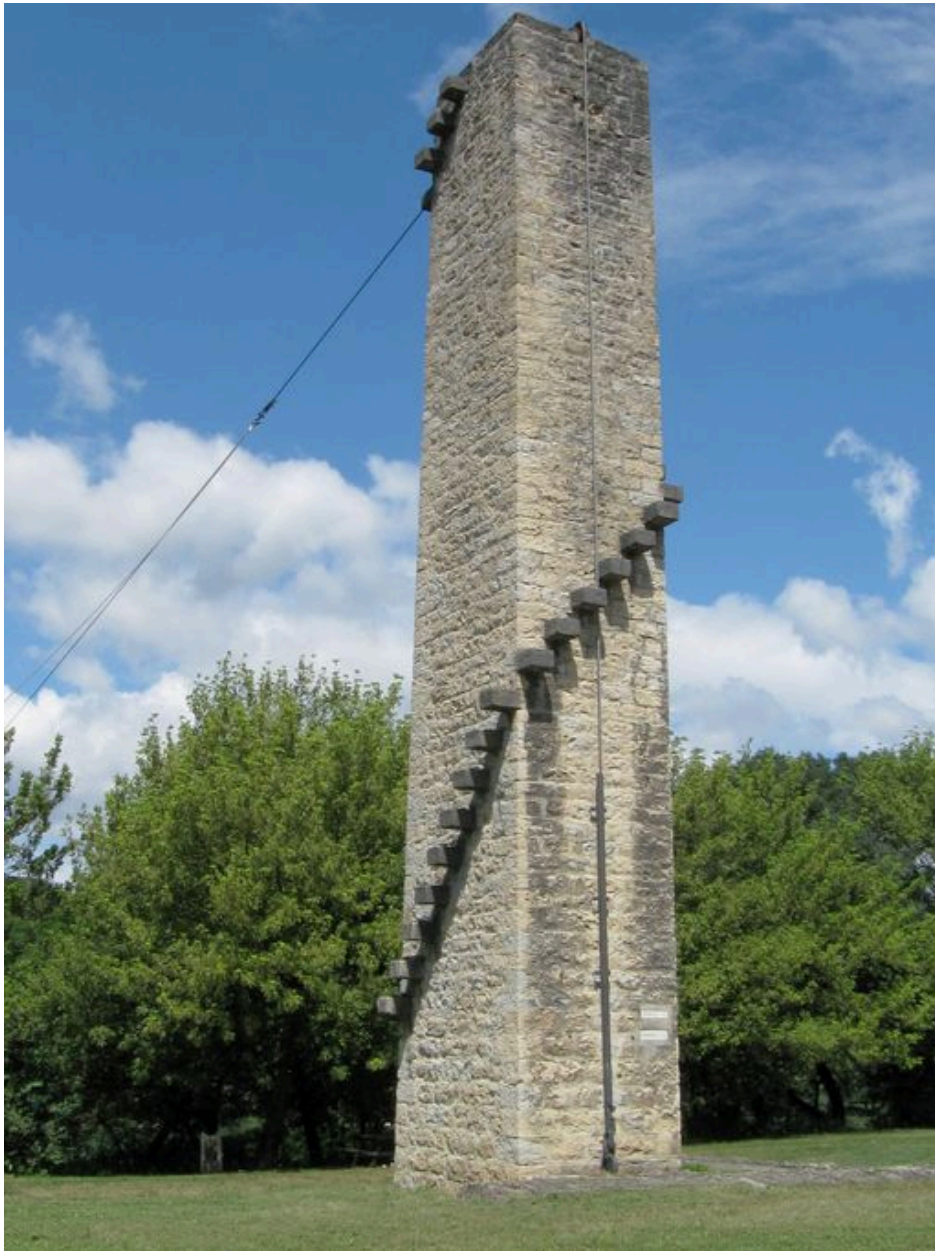
Pile gauche, angle sud-est, vue générale (depuis la rive gauche)
