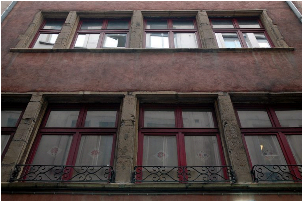
Élévation antérieure : détail de baies
