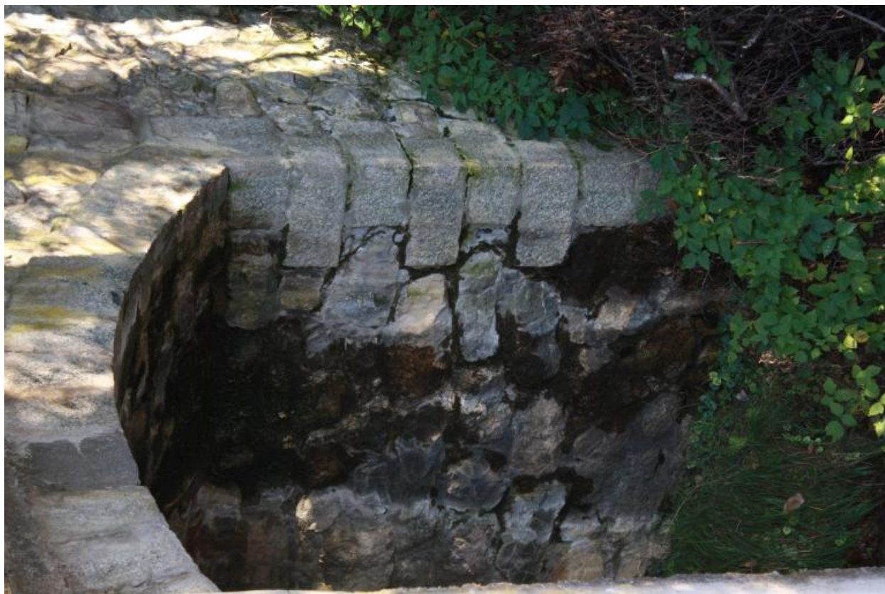
Pont du Martelet, détails bandeau et harpage
