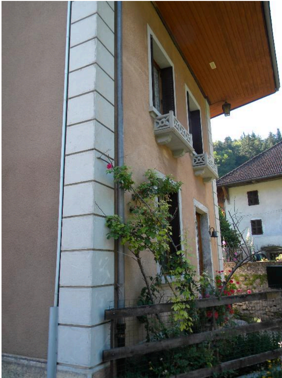
détail d'un chaînage droit (2008 D4 822).
