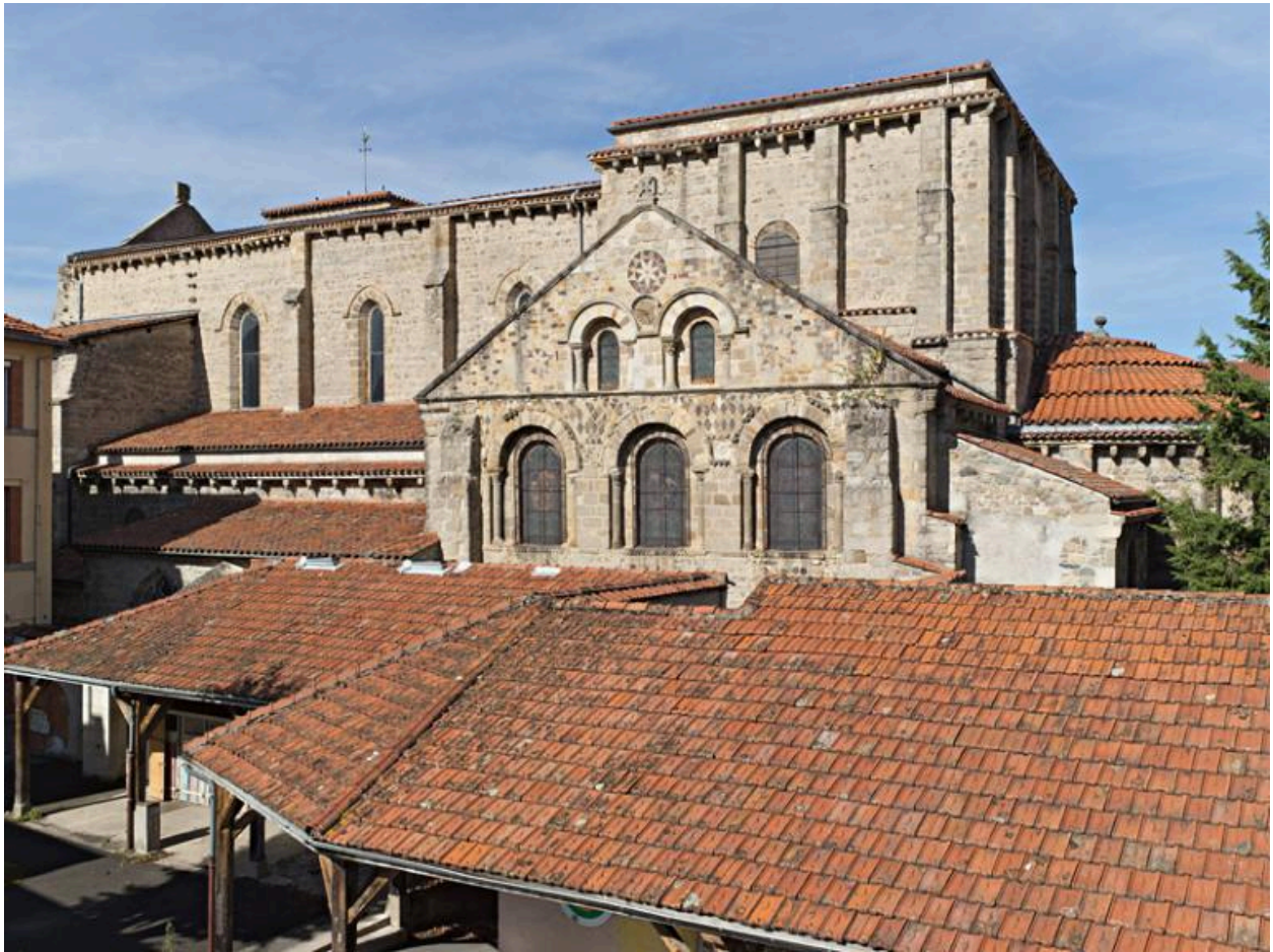
Parties hautes de l'élévation sud.
