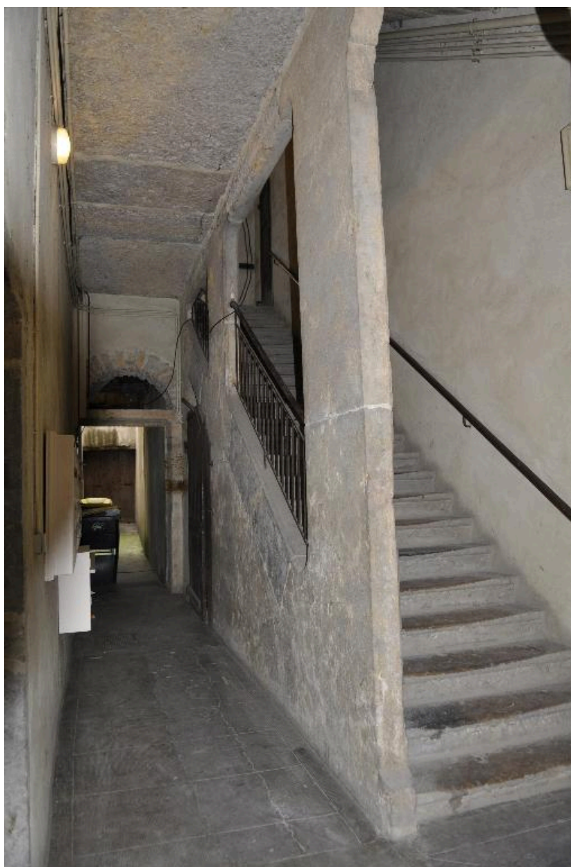
Départ de l'escalier du n°9 rue Dumenge
