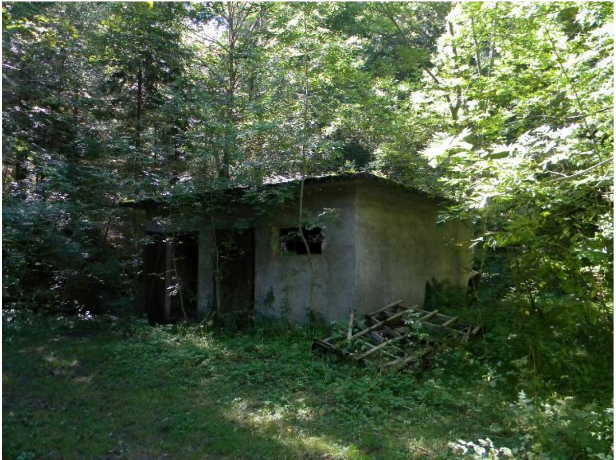
Vue d'ensemble du bâtiment du puits de mine.
