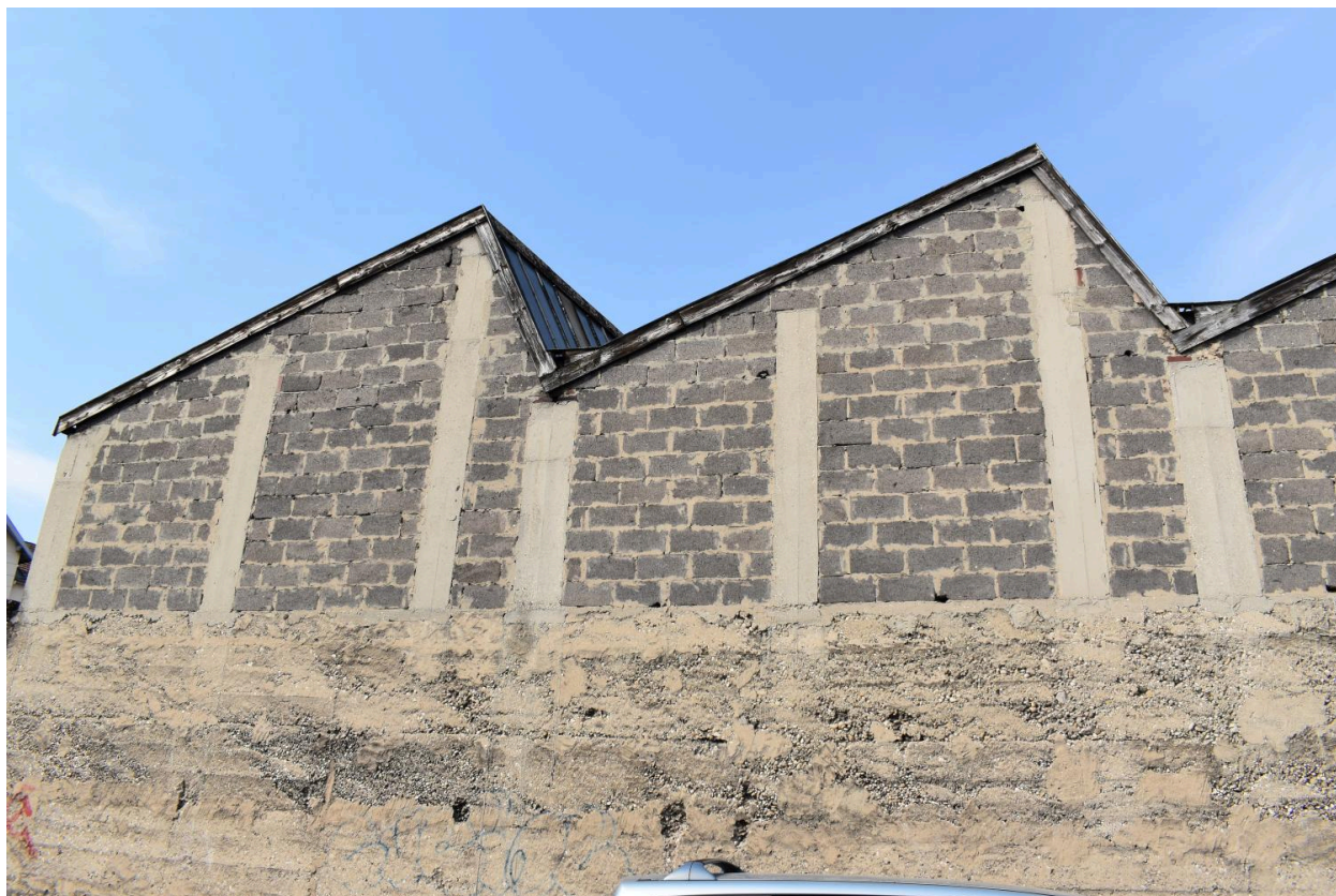
Usine Chimiotecnica - rue Marx Dormoy - détail de parpaings en pisé de mâchefer
