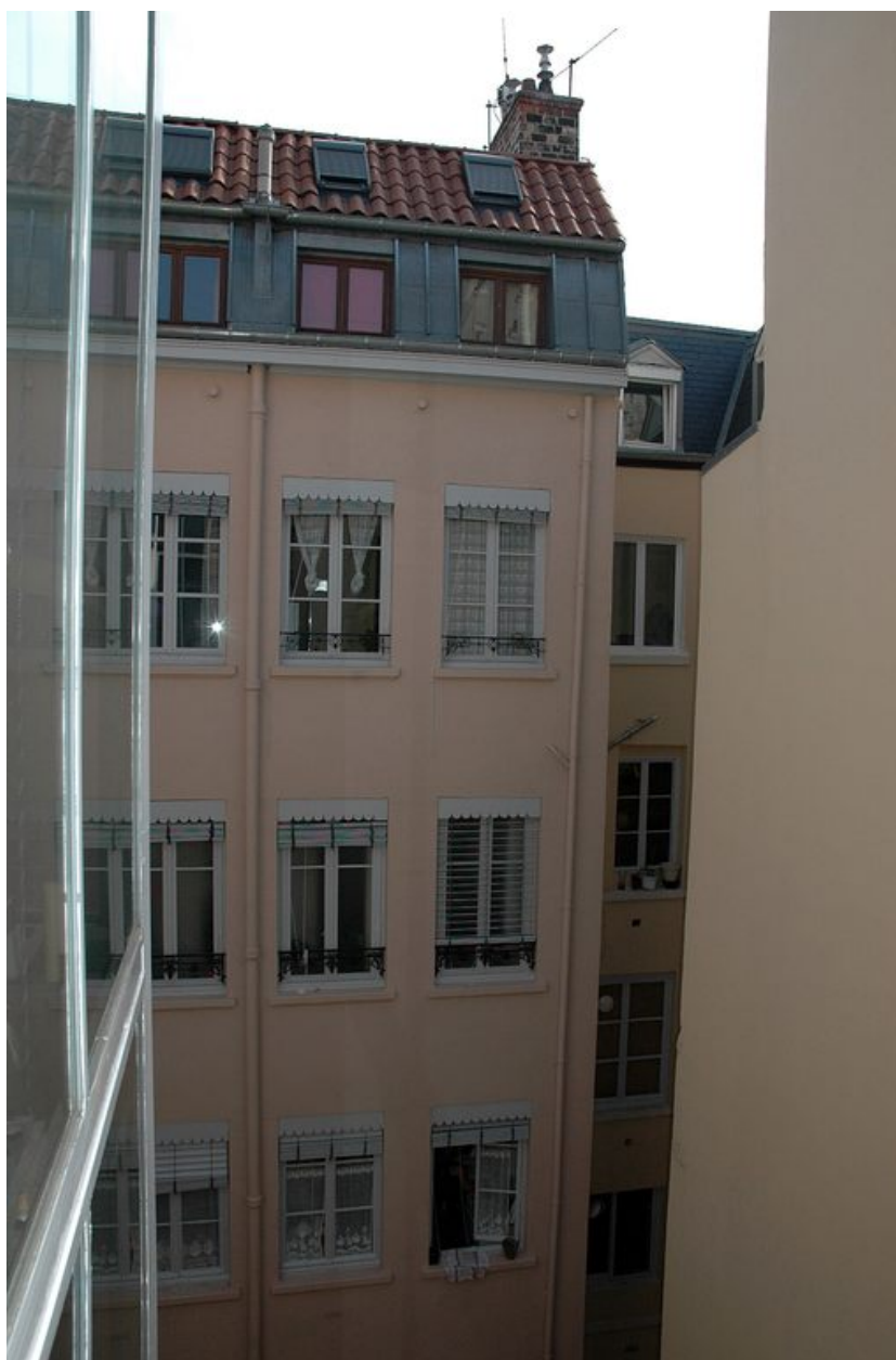
Elévation sur cour depuis l'immeuble adressé 8 rue Ferrandière
