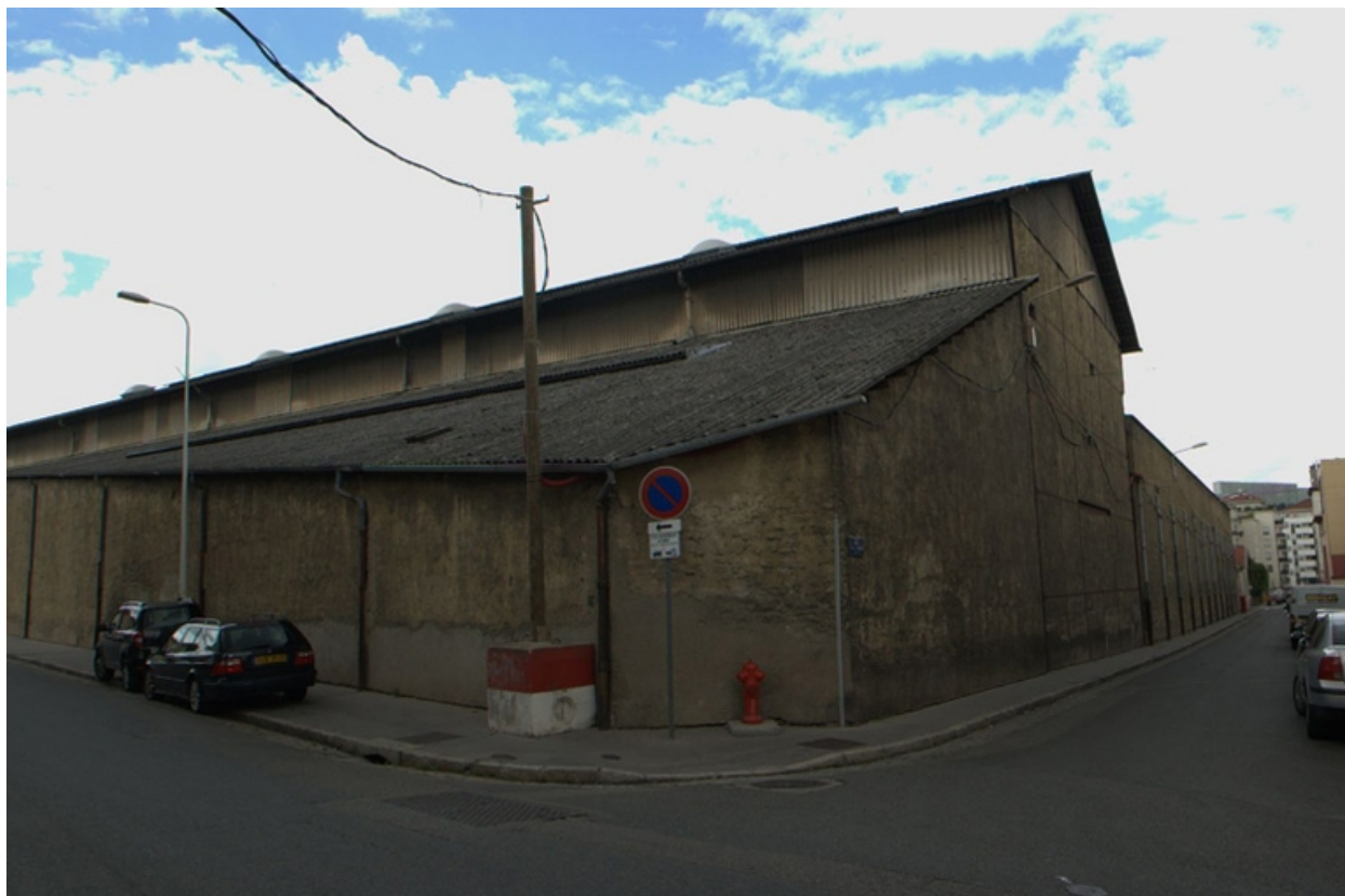
Vue de la halle est-ouest
