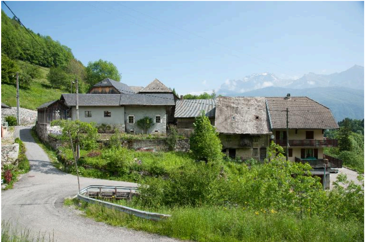
Vue d'ensemble du hameau depuis la route de Montgellaz
