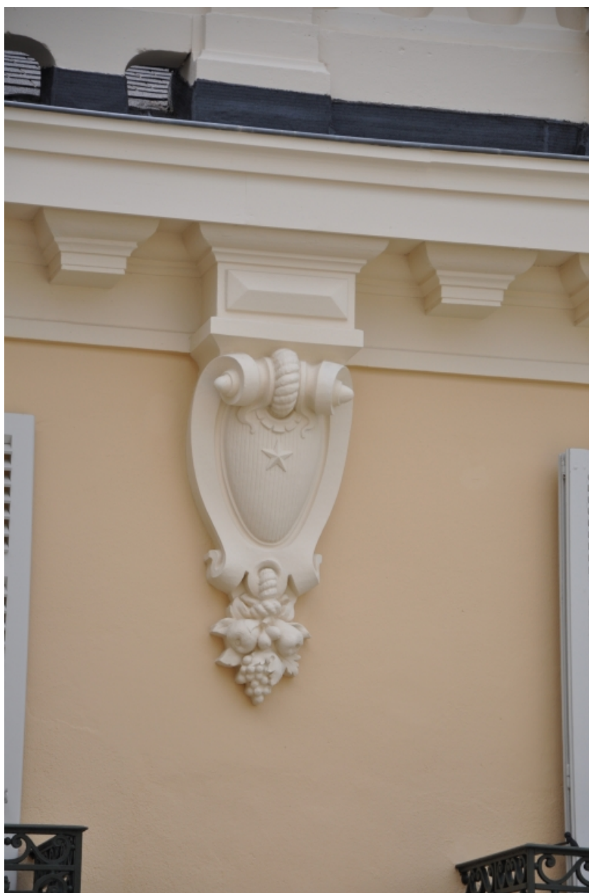
Cartouche de la façade nord
