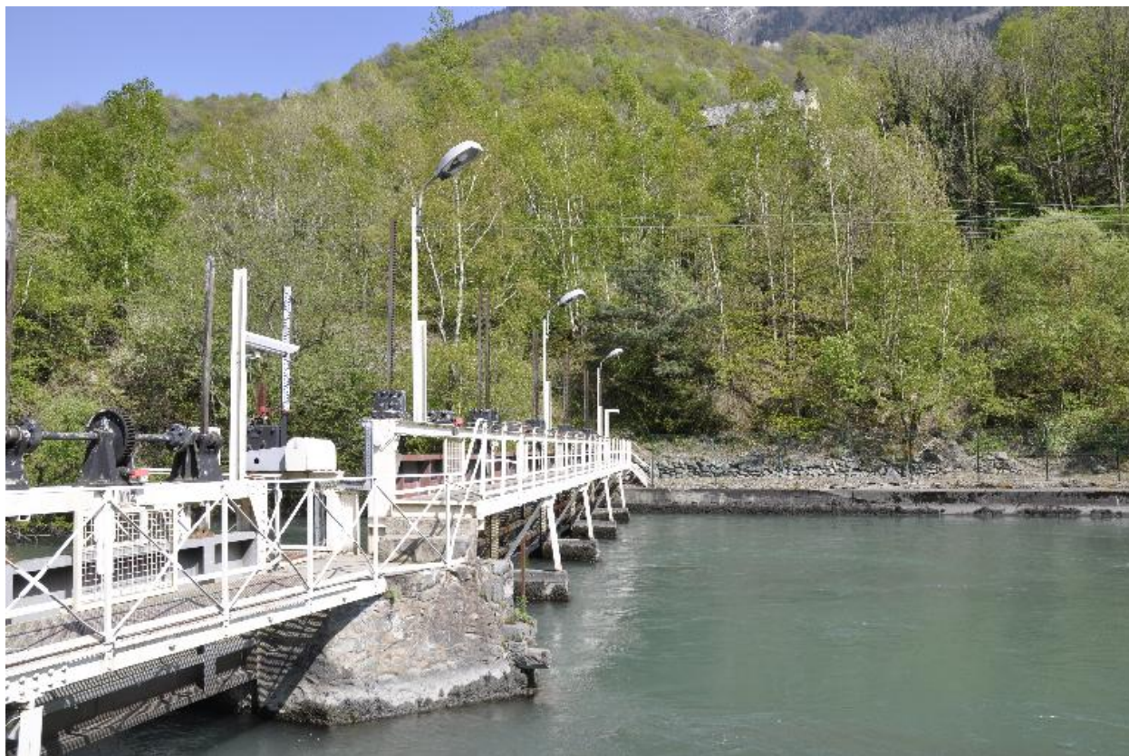
Vue du barrage
