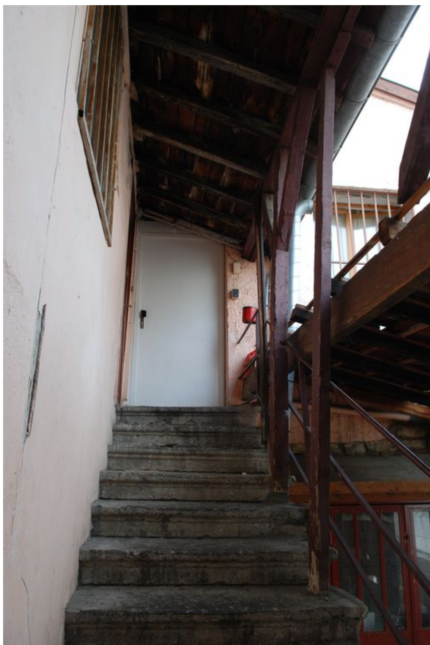
Détail de l'escalier extérieur en équerre, situé au nord-est.
