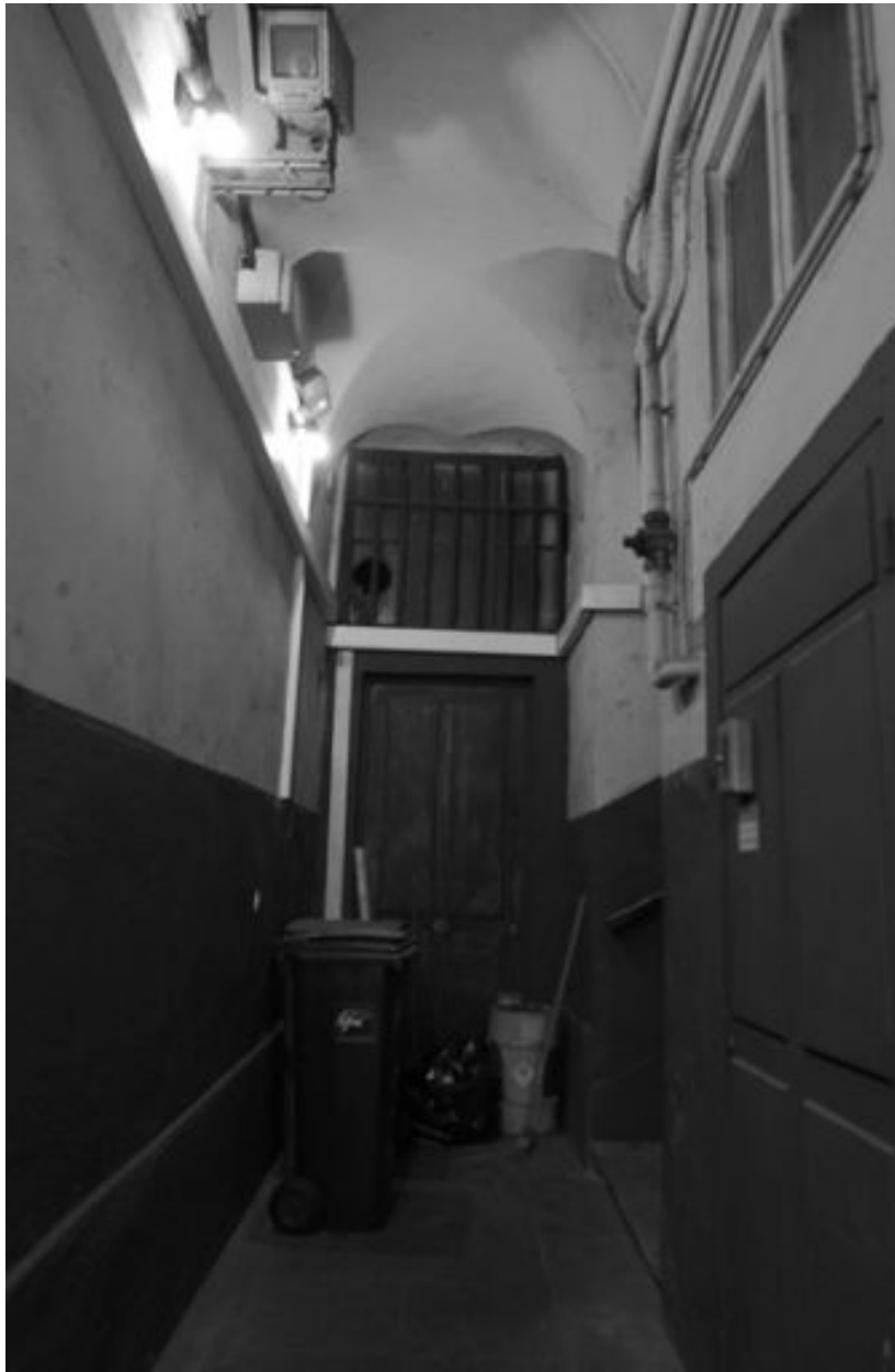
Allée vue en direction de l'ancienne entrée rue des Forces et départ du 2e escalier
