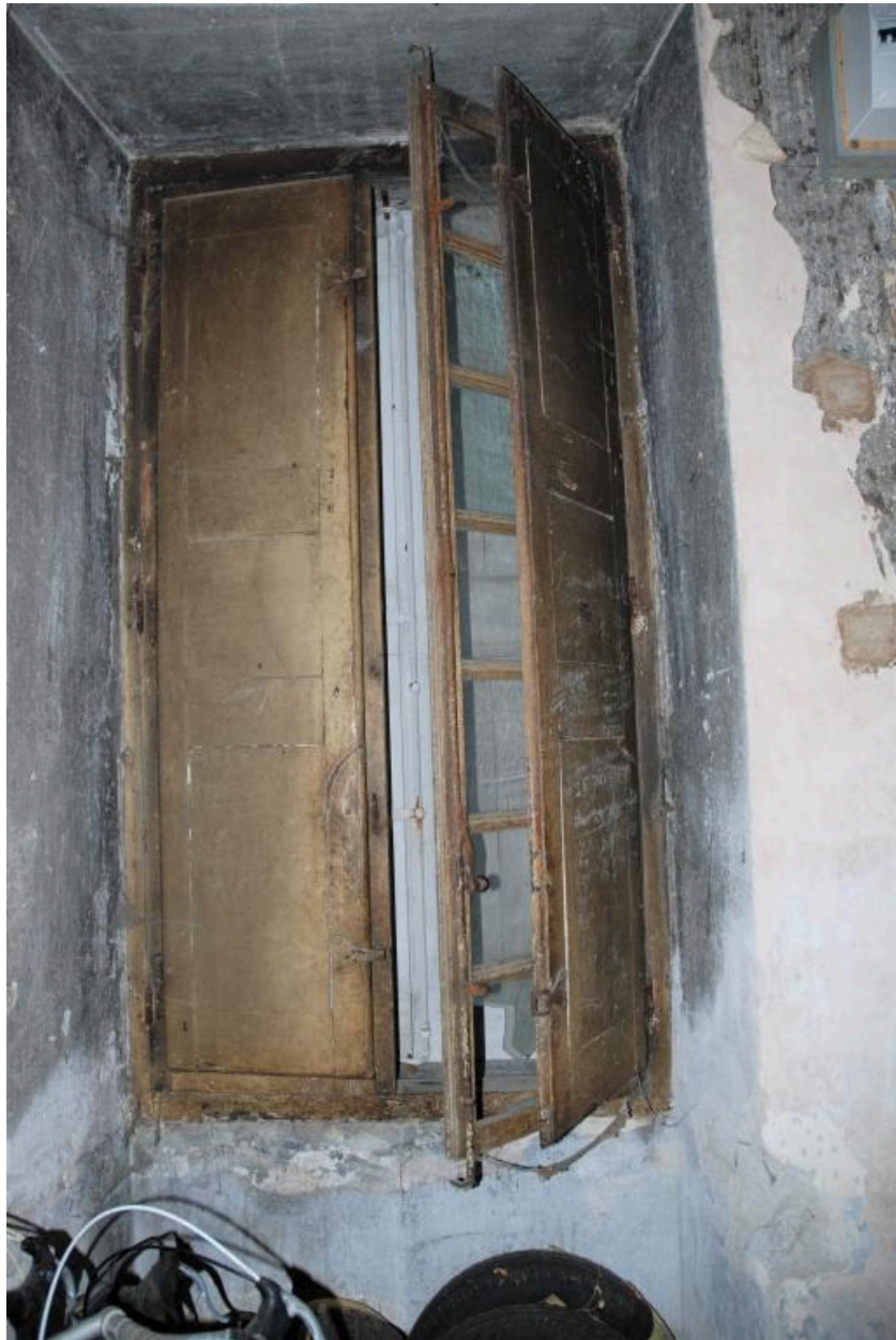
Corps principal, rez-de-chaussée, partie nord, ancienne cuisine (Cf. Plan RDC 3), fenêtre avec volets intérieurs.
