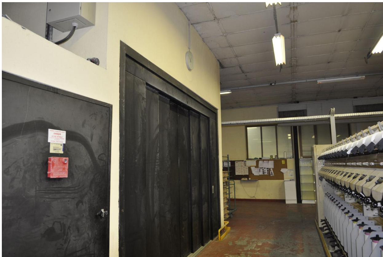
Monte-charges (vue d'intérieur)
