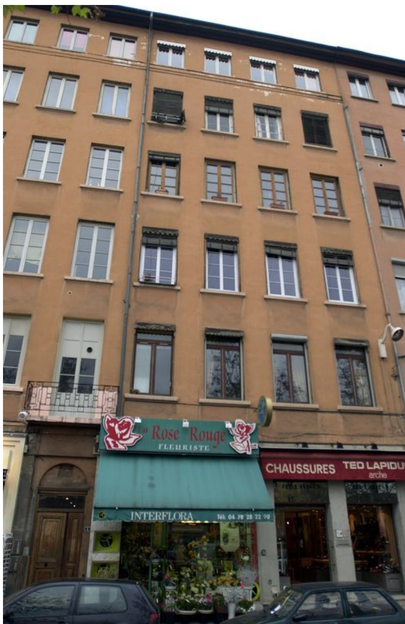
Façade sur rue, partie droite
